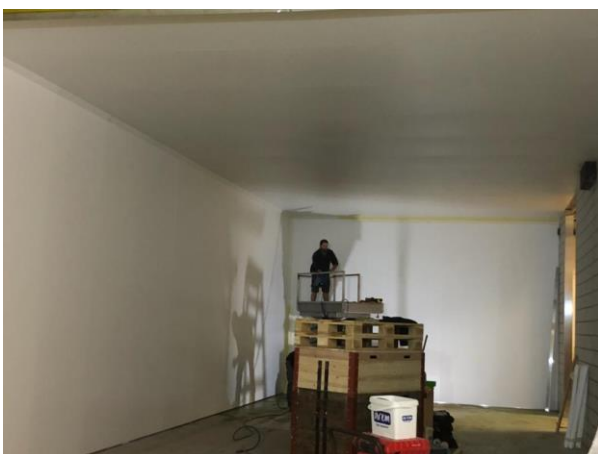
Einbringen von Hygiene Paneelen an Wände und Decke
