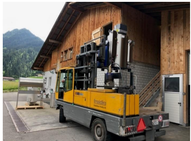
Einbringen des Dampferzeugers
